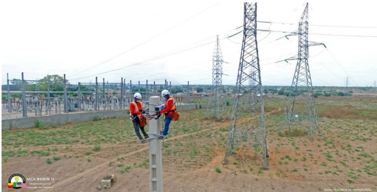
Image 2 : Mise à niveau des lignes électriques à Parakou.
