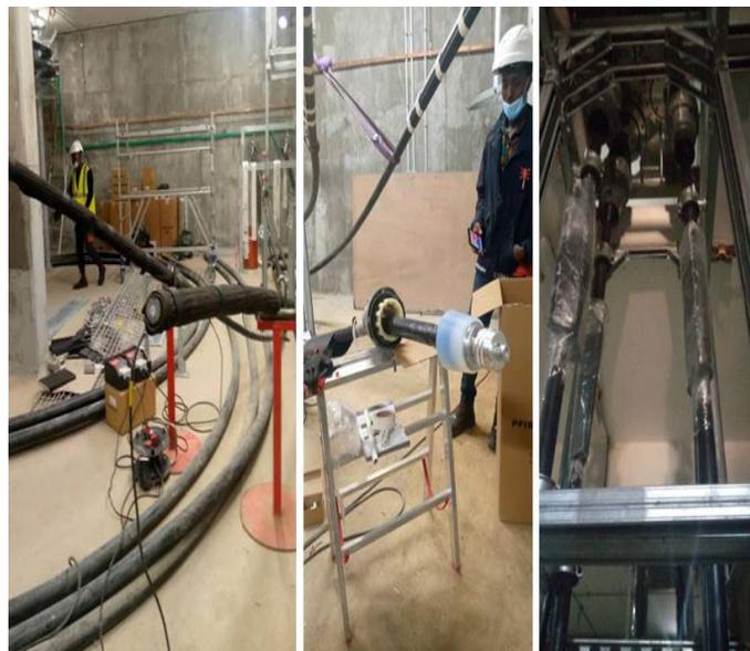
**Essais de gaine avant et après tirage des câbles 63kV de VFCA**
