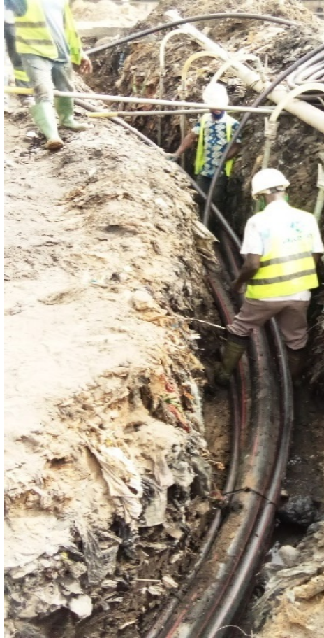
LIAISON GBEDJROMEDE - CROIX ROUGE (GC) : Pose de fourreaux
