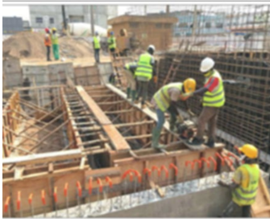
Travaux de ferrailage et de coulage de béton
