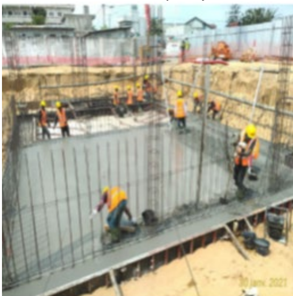
Coulage du radier des murs du bâtiment Contrôle Commande Numérique Fidjrossè
