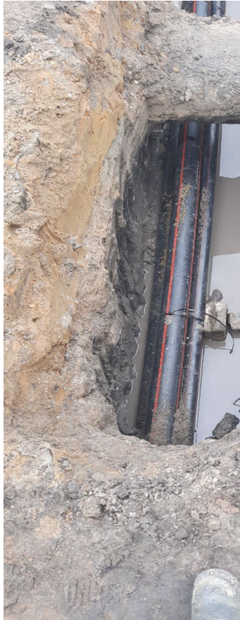
LIAISON VEDOKO - GBEDJROMEDE (VG) : Passage sous blocs de béton
