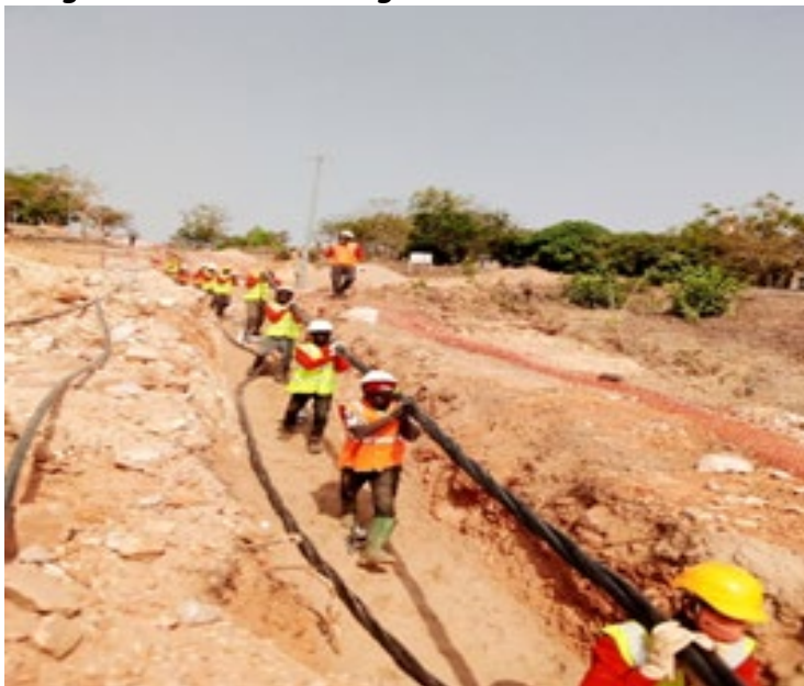
Tirage de câble et poteaux entreposés à Parakou
