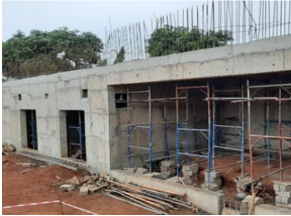
Bâtiment de Dispatching en chantier sur le site de Bohicon
