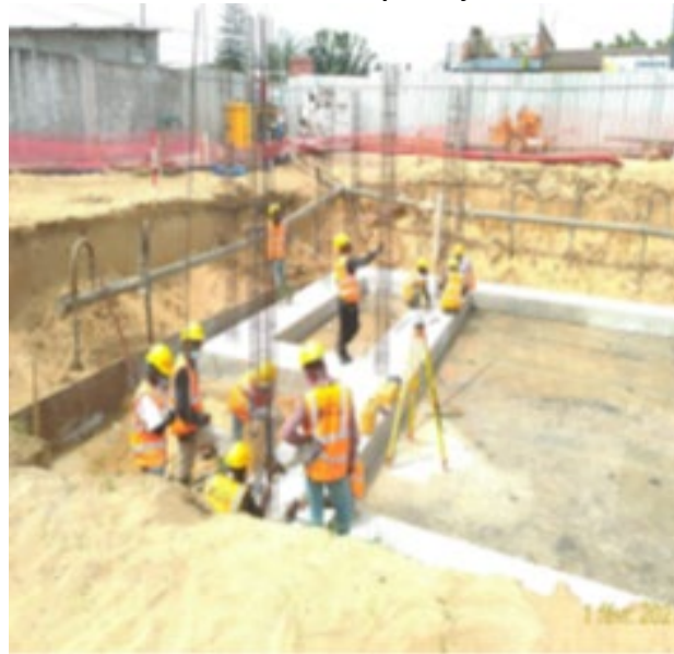
Ferrailage des murs du bâtiment Contrôle Commande Numérique Fidjrossè
