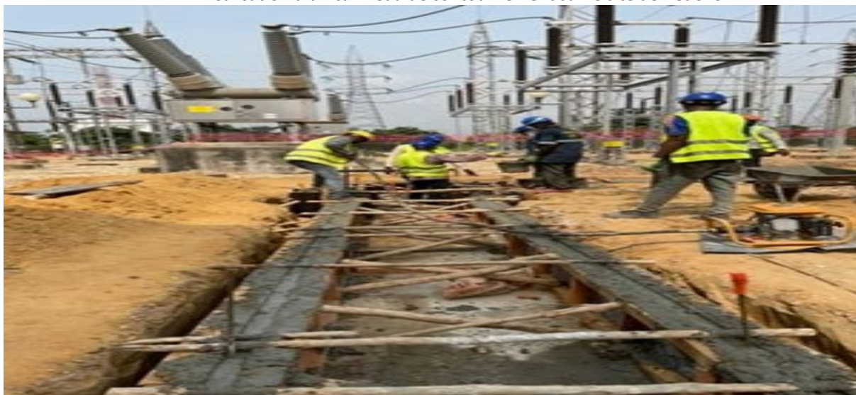
Réalisation d'un caniveau de contournement sur le site de Vêdoko
