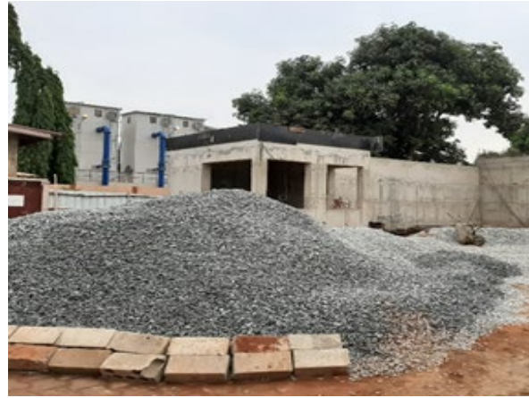
Local du Groupe électrogène en chantier sur le site de Bohicon
