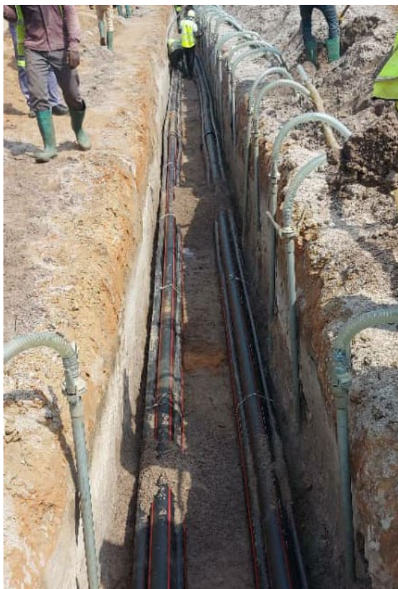
Image 3 : Travaux d'ouverture des tranchées et pose des fourreaux : Liaison AKPAKPA – CIM-BENIN – CROIX ROUGE
