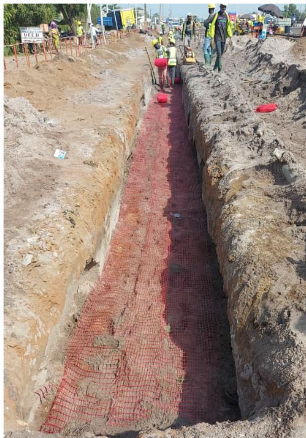
Image 3 : Travaux d'ouverture des tranchées et pose des fourreaux : Liaison AKPAKPA – CIM-BENIN – CROIX ROUGE
