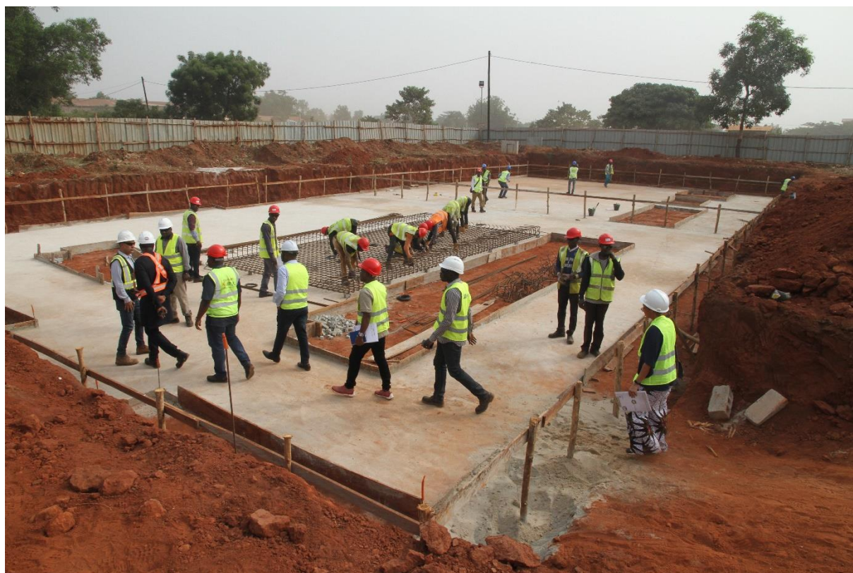
Image n° 2 : Visite du chantier de construction du bâtiment du dispatching à Akassato
