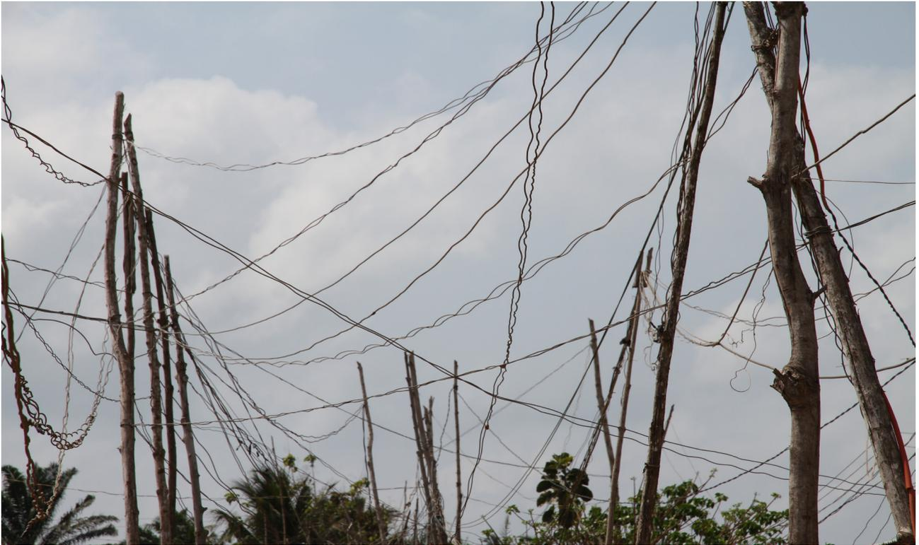
*L'un des problèmes de la distribution est que le réseau, vétuste, est chargé d'un réseau parallèle, appelé «toile d'araignée». Il est à l'origine d'une perte d'environ 20 % de l'énergie qu'il transporte. (Image MCA-Bénin II).*
