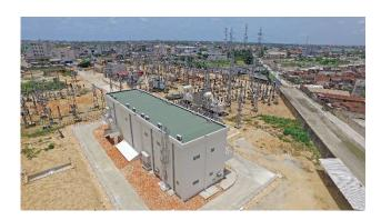
C'est le poste source principal qui alimente la nouvelle boucle 63 kV de Cotonou avec ses 7 nouveaux postes GIS. Il est alimenté par les postes d'interconnexion 161 kV de Momé Hagou avec la VRA au GHANA via le Togo et 330 kV de IKEDJA avec la TCN au Nigéria via Sakété au Bénin. De par sa position, Il dessert tous les autres postes existants AIS et GIS de la ville de Cotonou.
