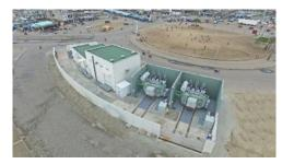
Il est d'une architecture spécialement conçue pour s'intégrer harmonieusement à l'aménagement paysager de ce grand carrefour giratoire connu pour l'intensité de son trafic camions gros porteurs, et ses murs extérieurs, mécaniquement surdimensionnés pour résister aux chocs extérieurs de haute intensité en vue de prévenir et sécuriser les infrastructures du poste, le personnel exploitant, des dérives éventuelles de gros engins en perte de repère ou de vitesse accidentelle.
