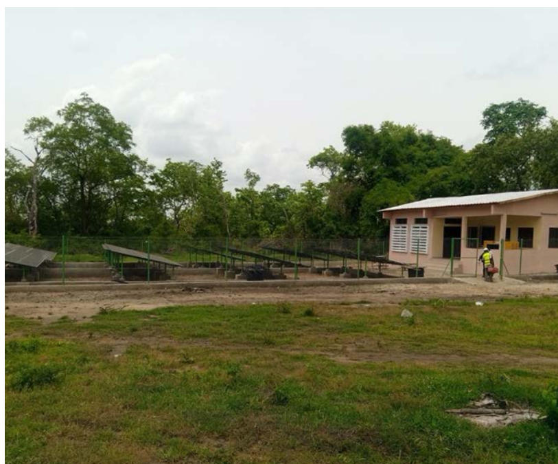
Mini-réseau de Djabata dans l'arrondissement de Bessé - Commune de Savè (Promoteur ASEMI)
