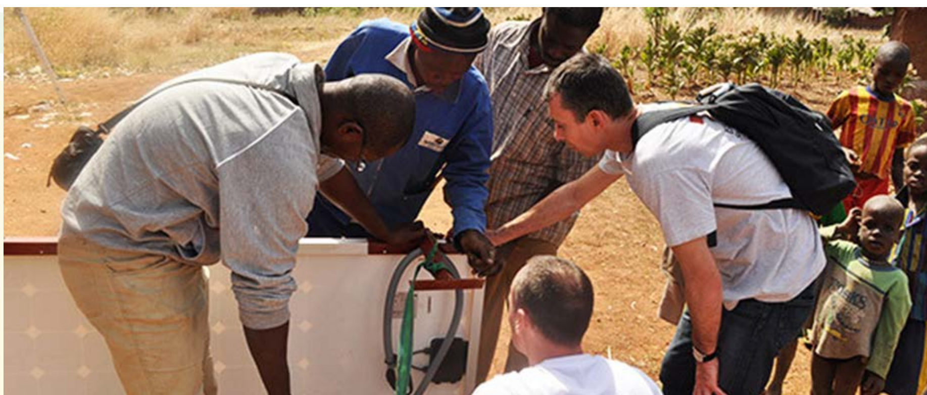
Vérification des caractéristiques du panneau à installer à Djèkpé avant installation Commune de So-Ava (Promoteur ESF - Électriciens Sans Frontières)
